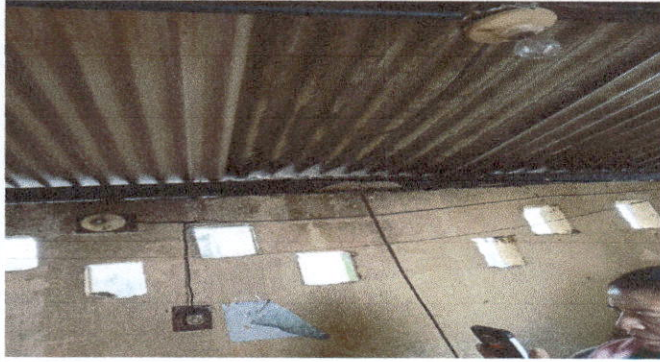
Foto 7: Reparación del sistema eléctrico.
