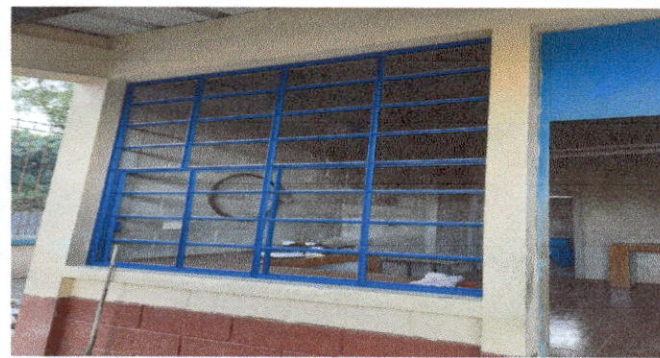
Foto 9: Mantenimiento a estructura de metal de ventana.
