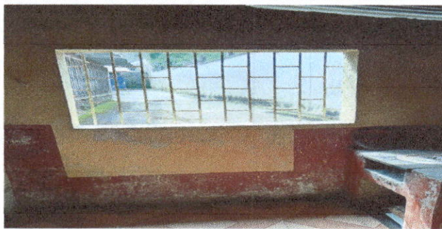
Foto 5: Sustitución de ventana de metal por ventana de pvc.
