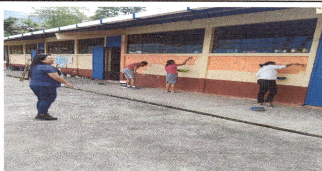
Foto 18. Pintura en muros interiores y exteriores.
