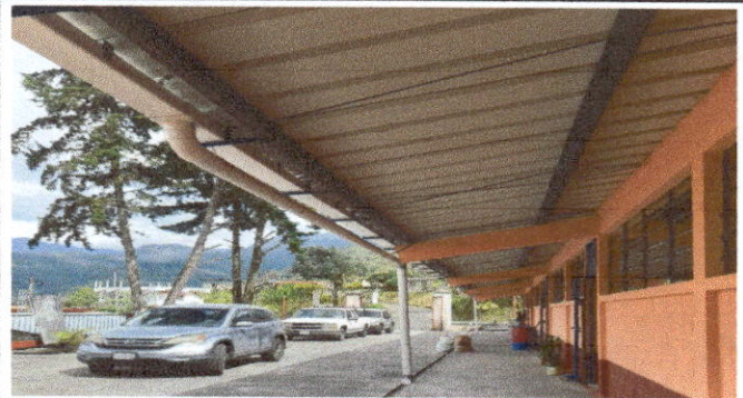
Foto 10: Sustitución de canales y bajadas de agua pluvial.
