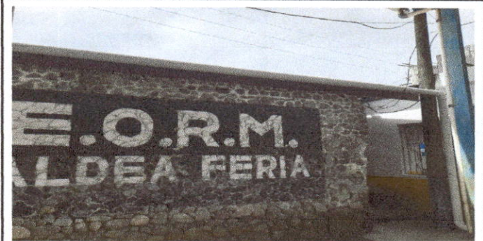
Foto 6: Sustitución de canales y bajadas de agua pluvial de pvc.
