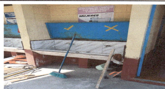
foto 16: Sustitución de azulejo.
