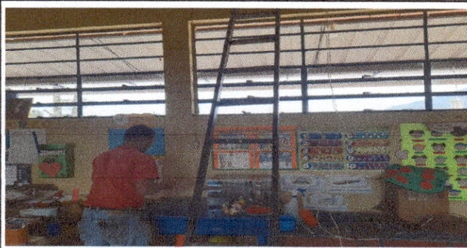
Foto 11: Reparación del sistema eléctrico más accesorios.
