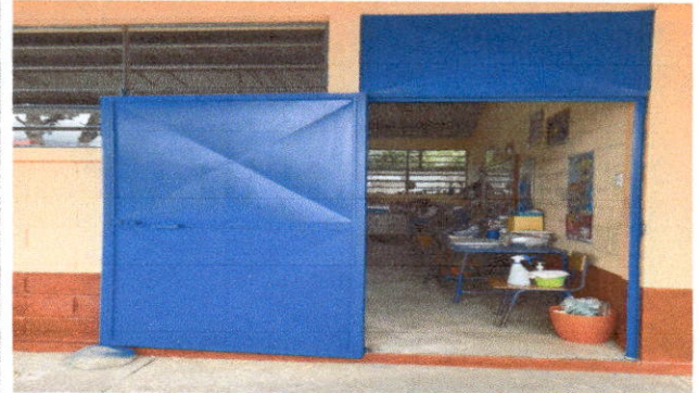
Foto 8: Puertas. Mantenimiento a estructura (lijado, cepillado, aplicación de pintura).
