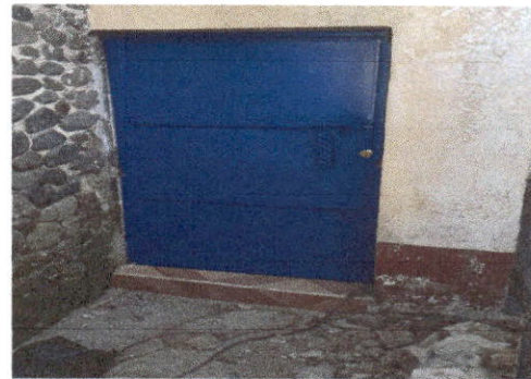
Foto 4: Fabricación e instalación de puerta de metal en módulos.
